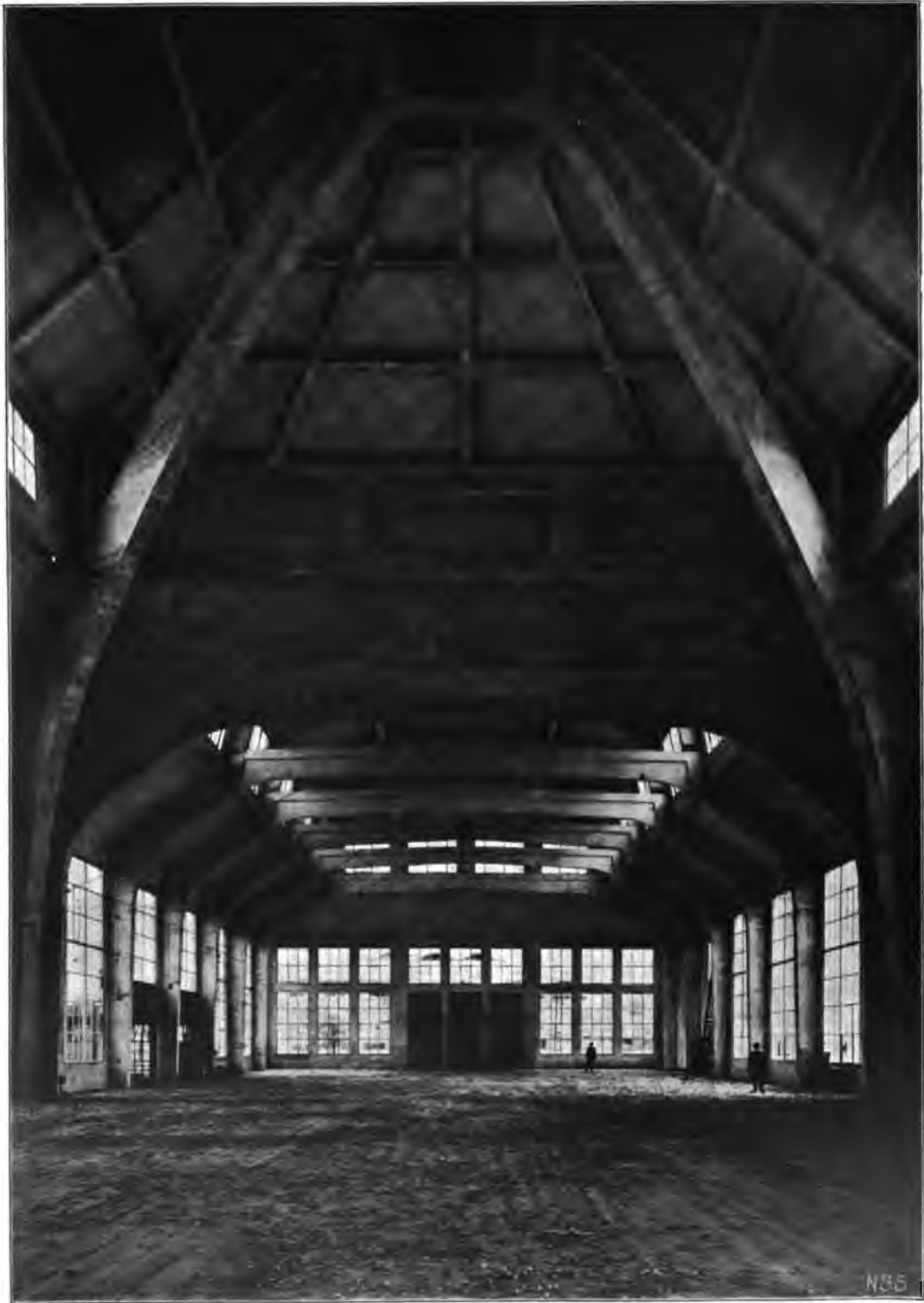
Abb. 67. Halle III im Münchener Ausstellungspark; Kuppelraum. Arch. W. Bertsch.
